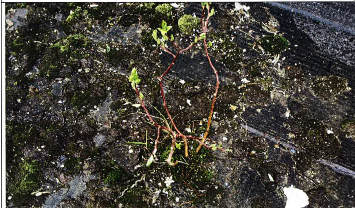
Bilde nr: 2-40 Bygningsdel/lokalisering: Over garasje/lager
