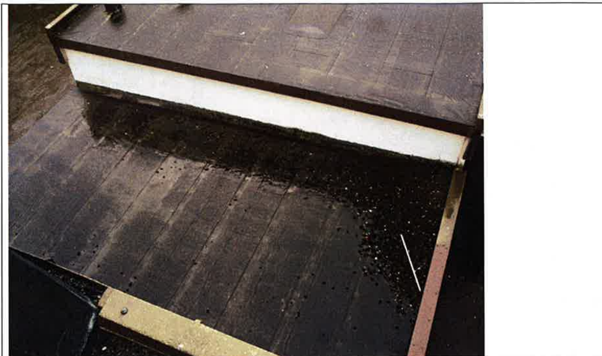
Bilde nr: 2-39 Bygningsdel/lokalisering: Tak over garasje og lager.
