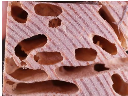
Foto 2. Fordi larvene fordøyer treverket, blir treverket ødelagt.
