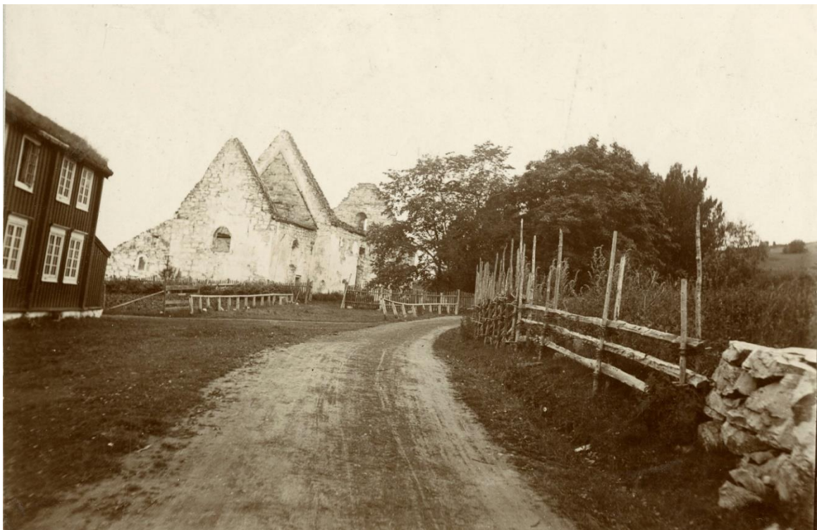
Figur 8 Kirken fotografert etter at takene er revet, men med mye puss bevar. Det ser imidlertid ut som om pussen stort sett forvitret ganske raskt da kirken ble stående åpen. Foto: Riksantikvaren.
