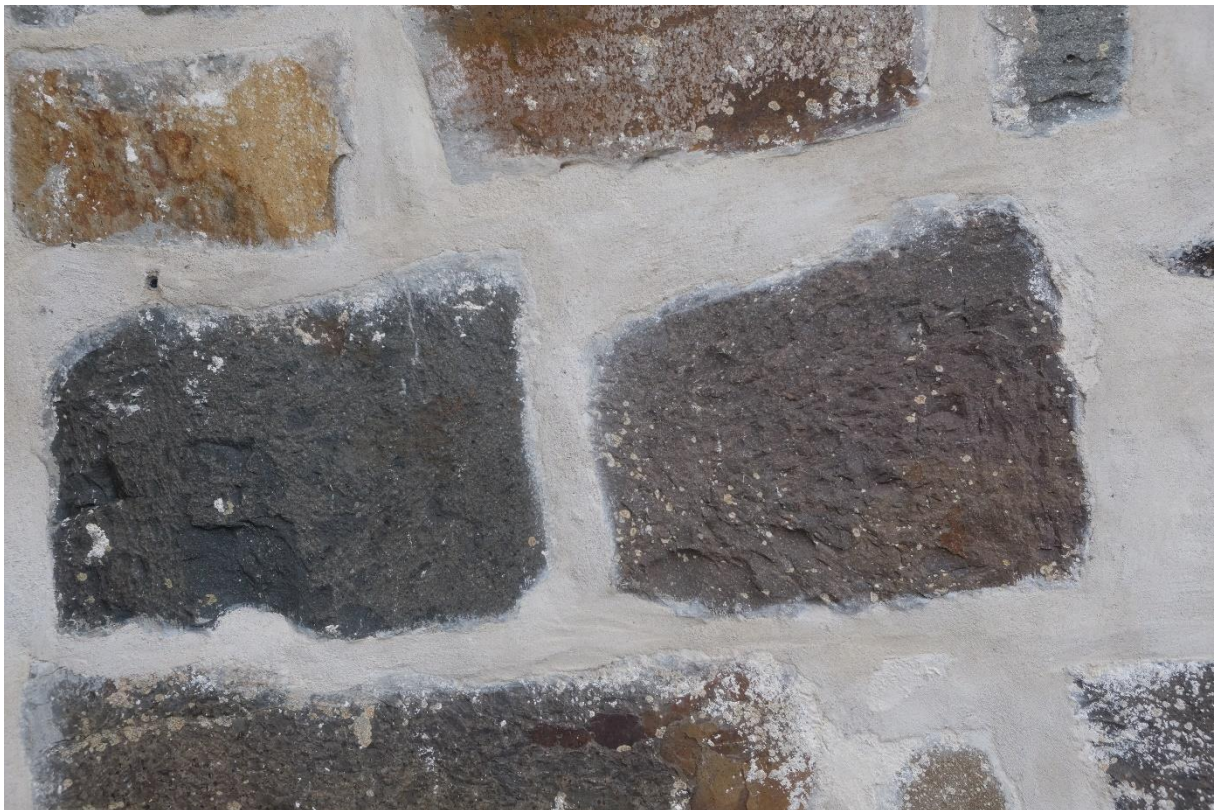
Figur 21 Nye, meddratte kalkfuger basert på tradisjonsbrent, svakt til middels hydraulisk ortocerkalk fra Ringsaker på korets sørvegg, Gamle Tingelstad, Hadeland. Dette er en restaurering av murverket hvor 1900-tallets sementfuger er forsøkt videreført med kalk. Det stiller svært store krav til kalk og utførelse og vil neppe stå seg i et fuktigere klima.
