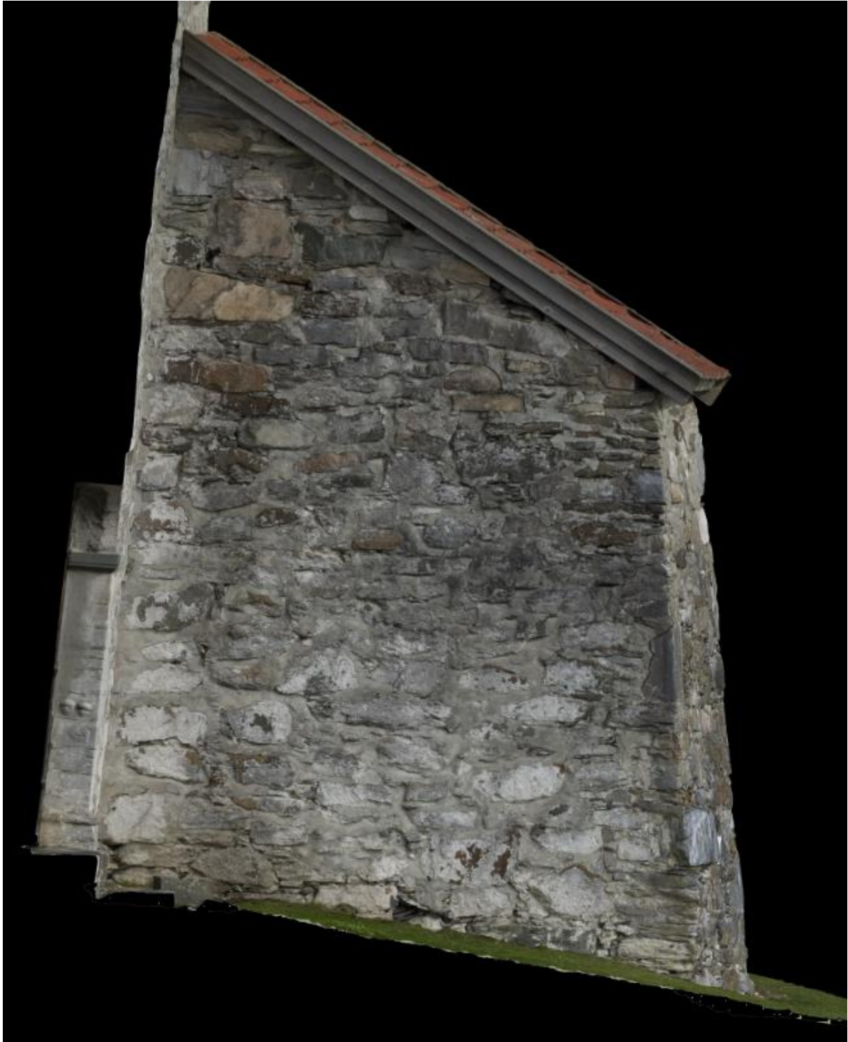
Figur 18 Hele det utvendige murverket er dokumentert med fotogrammetri med høy oppløsning slik at både steinbruk og murverk fortsatt vil kunne studeres selv om overflatene blir kalket. Fotogrammetri: Past AS mai 2023.
