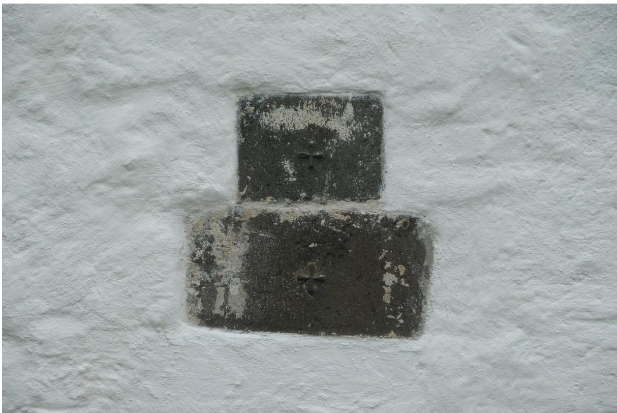
Figur 23 Detalj som viser Mariakirkens murverk etter at den har fått meddratte kalkfuger og en tynn sekkeskurt puss ut over steinflatene.
