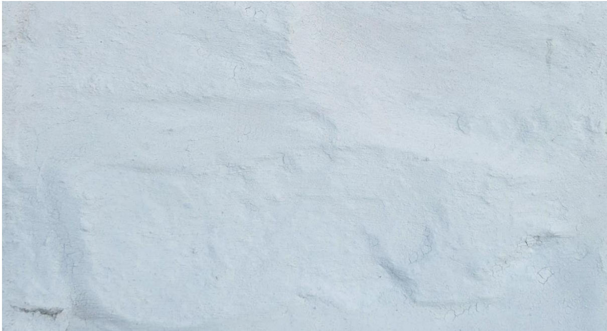
Figur 24 Meddratte fuger, tynt påkast med puss, sekkeskuring, slemming og hvitning, Hesby kirke, Stavanger.
