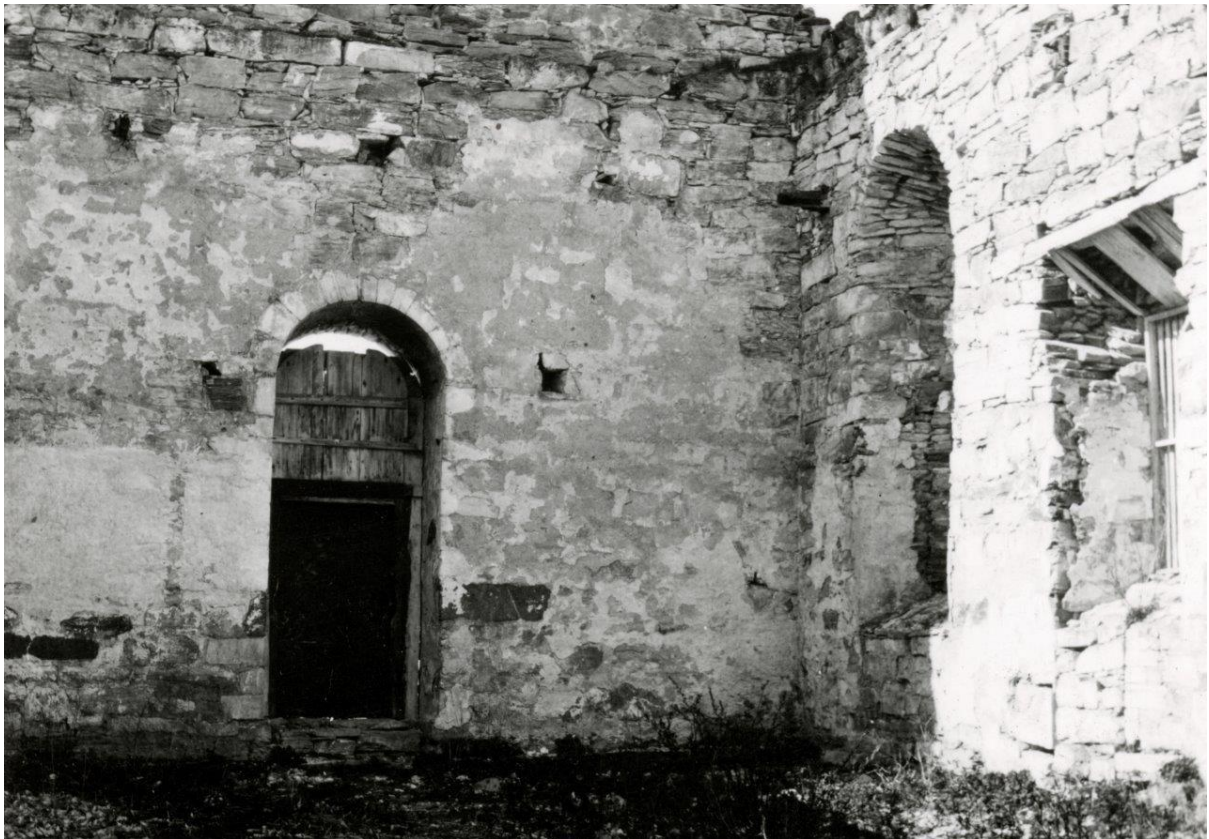
Figur 11 Pussen på vestgavlens innside er ganske godt bevart og gir et inntrykk av hvordan interiøret var med en tykkere puss enn dagens slemming. Foto: Riksantikvaren.
