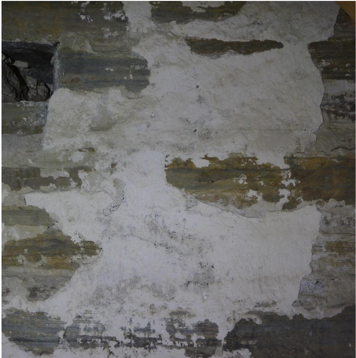
Figur 25 Bevart middelaldersk, utvendig kalkpuss som ble innbygget da sakristiet ble tilføyd på Værnes kirke. Muren fremstår med meddratte fuger og en tynn puss.
