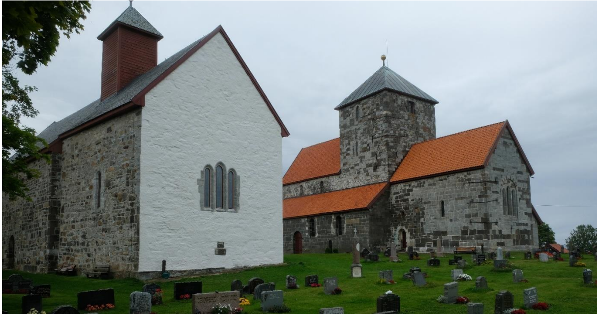
Figur 22 Mariakirken er den sørligste av Søsterkirken på Gran. I 2022 ble korets østgavl pusset og arbeidet fortsetter nå rundt kirken. Begrunnelsen var i utgangspunktet teknisk for å stoppe forvitring av steinoverflater og kalkfuger, men også her er det en tilbakeføring til opprinnelig overflate. Arbeidet er utført med sub-hydraulisk, tradisjonsbrent kalk fra Toten.
