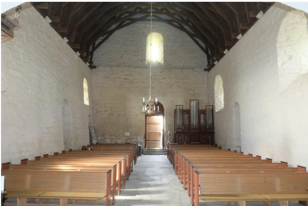
Figur 16 Kirkens interiør har en kalkslemming som er langt tynnere enn den opprinnelige pussen.
