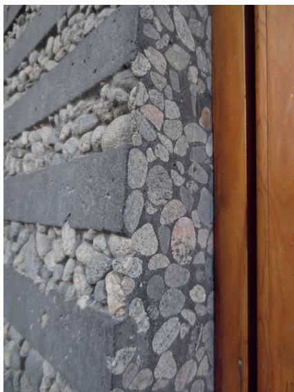
Snitt gjennom naturbetong, der elvesteinene ligger tett i tett gjennom hele veggen. Paviljong i regjeringskvartalet. Foto: Siri Hoem
