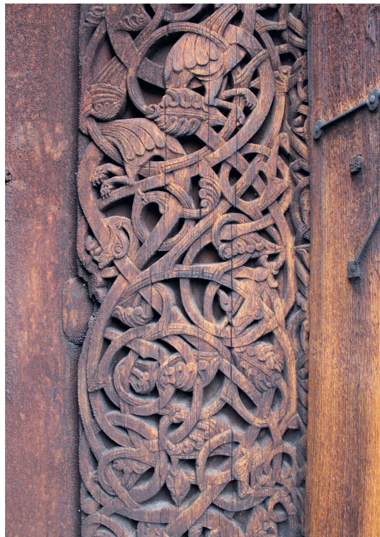
Typisk ornamentikk i stavkirke. Utskjæringene kan ikke skilles fra bygnings- materialet. Foto: Linn Willetts Borgen
