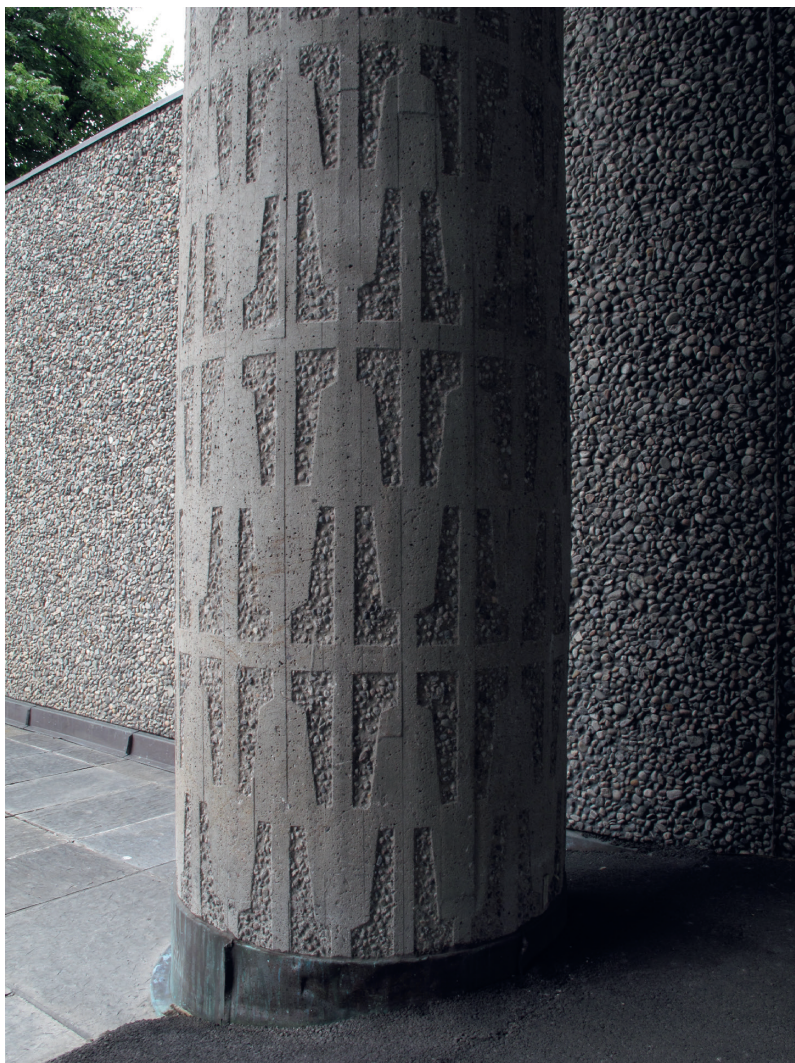
Søyle i Høyblokka med sandblåst mønster i betong, inspirert av stavkirkenes treskjærerkunst. Ornamentikken inngår i det bærende materialet. Foto: Siri Hoem
