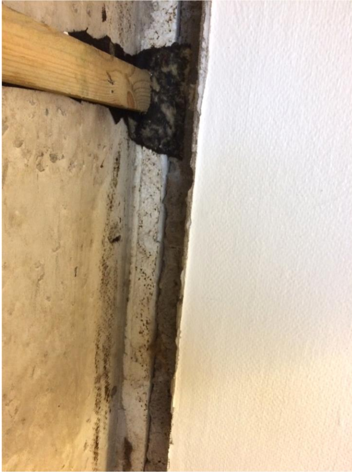
Bilde av overgang gavlvegg/hvelvvegg med isopor mellom, gavlvegg til venstre.
