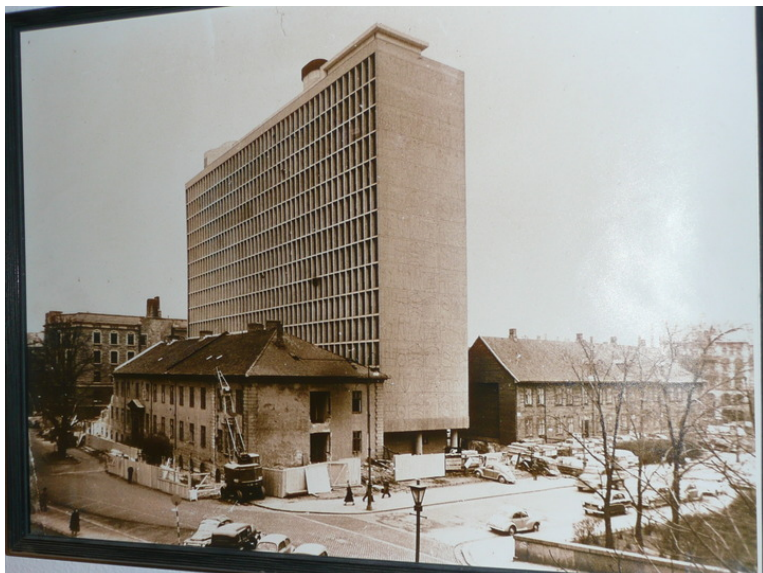
Høyblokken under oppførelse. Rikshospitalets gamle bygninger er ennå ikke revet. Opphavsrett: Statsbygg.
