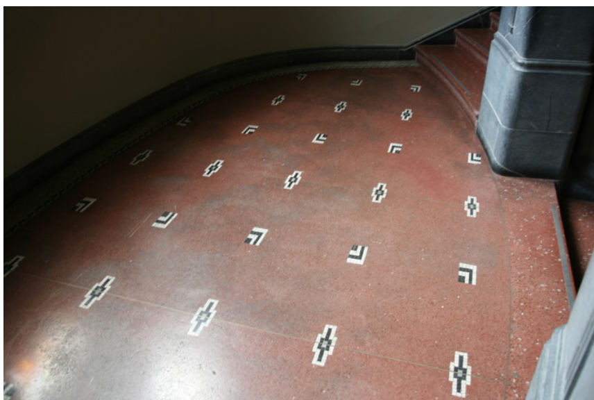
Bygningen har et detaljningsnivå ned på dekor i gulv i trappeoppgangene. Opphavsrett: Statsbygg.
