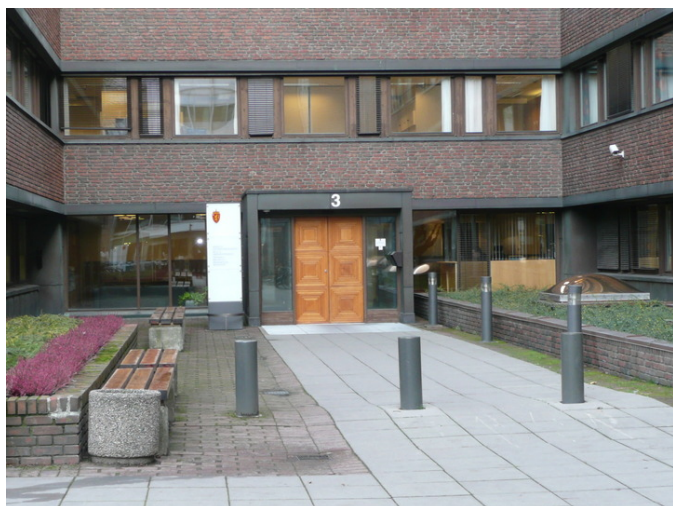
Inngangspartiet til S-blokken uttrykker nøkternhet. Opphavsrett: Statsbygg.
