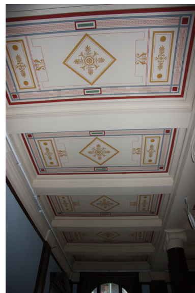
I ekspedisjonshallen i første etasje er takdekorasjonen rekonstruert; gammelt mønster er adekket. Opphavsrett: Statsbygg.
