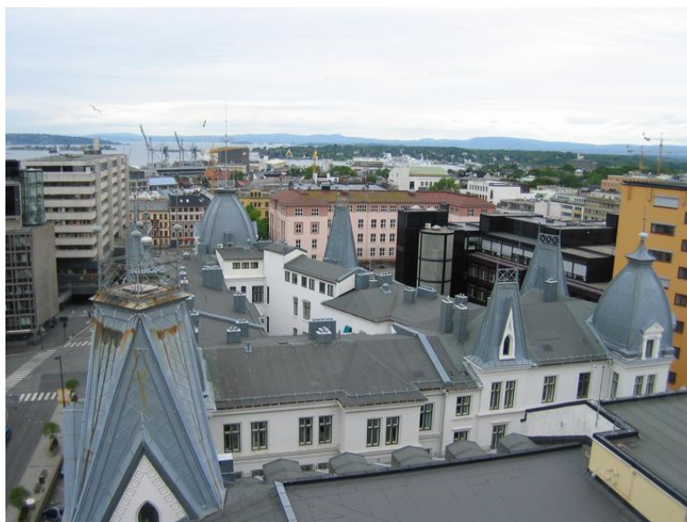
Taklandskapet på Sydkvartalet sett fra Midtkvartalet. Opphavsrett: Statsbygg.
