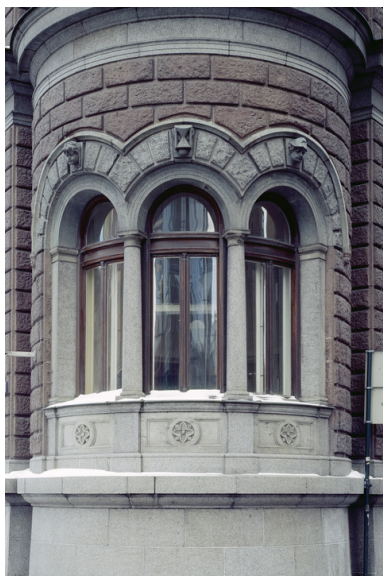
I hjørnet mellom Keysers gate og Munchs gate møtes fasadene i en rund bue. Foto: Jiri Havran. Opphavsrett: Statsbygg.
