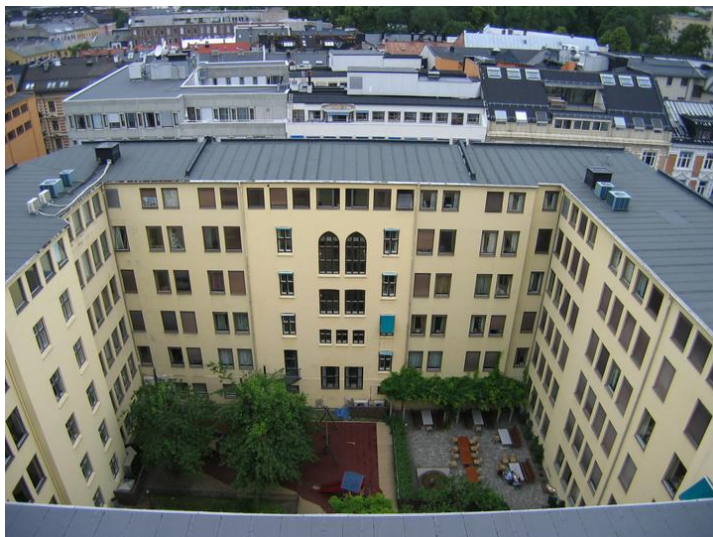
Bakgården sett fra taket. Opphavsrett: Statsbygg.
