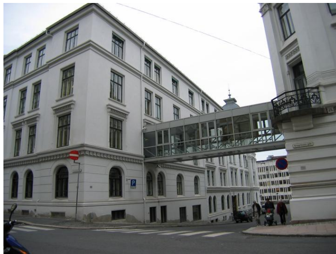
Fasade mot sydvest. Gangbro mellom Nord- og Midtkvartalet. Opphavsrett: Statsbygg.
