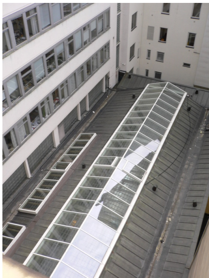
Overlys ned i rettsalene. Opphavsrett: Statsbygg.
