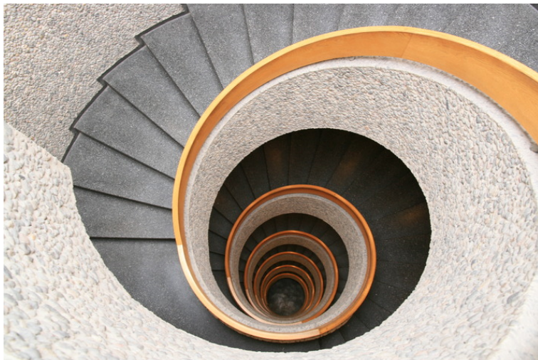
Hovedtrappeløpet sentralt i bygningen. Opphavsrett: Statsbygg.
