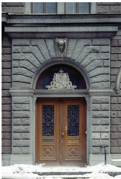
Hovedinngangen har omramming av larvikitt. Skjoldet over døren og hodet, utført av billedhuggeren Georg Andreas Heggelund, er begge i kleberstein. Foto: Jiri Havran. Opphavsrett: Statsbygg.
