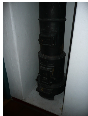
Nisje med ovn for opprinnelig oppvarming i kjelleretasjen. Opphavsrett: Statsbygg.
