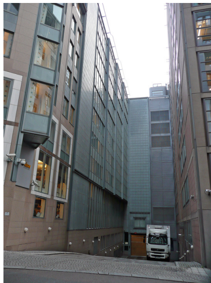
Vareinngang fra Munchs gate. Opphavsrett: Statsbygg.
