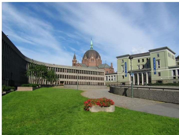
Y-blokkens nordfløy til venstre i bildet. Deichmanske bibliotek til høyre, og bakerst i bildet ligger Trefoldighetskirken. Området på den nordøstlige siden av anlegget er enkelt opparbeidet. Opphavsrett: Statsbygg.
