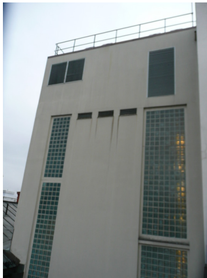
Fasade mot bakgård. Glassbyggerstein i trappeoppgangen. Opphavsrett: Statsbygg.
