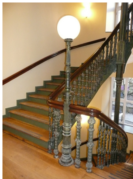
Ferdig restaurert hovedtrappeløp. Opphavsrett: Statsbygg.
