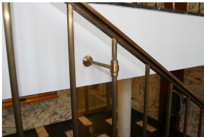
Detalj fra trappen i bygningen fra 1963. Opphavsrett: Statsbygg.
