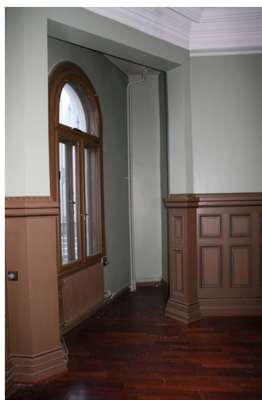
Originalt vindu og brystpanel. Opphavsrett: Statsbygg.
