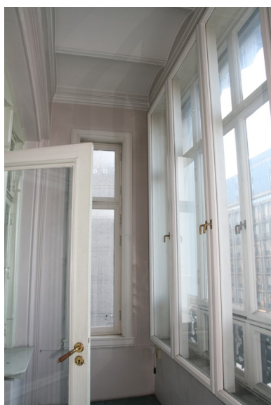
Doble vinduer mot syd i 3. og 4. etasje. Opphavsrett: Statsbygg.
