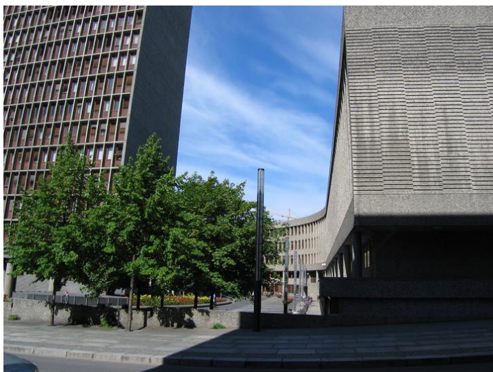
Bildet viser hvordan Y-blokken buer seg elegant rundt Høyblokken. Opphavsrett: Statsbygg.
