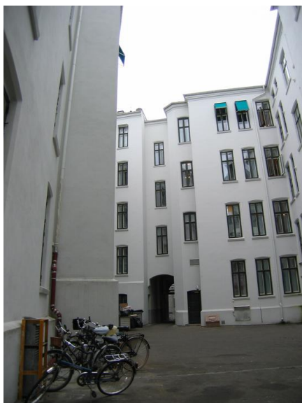
Fasade mot indre gårdsrom. Opphavsrett: Statsbygg.
