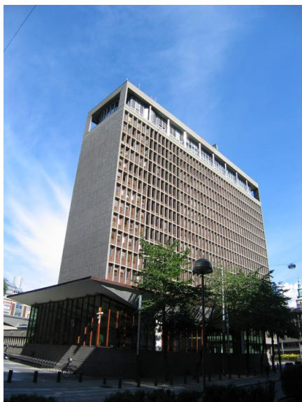
Høyblokken sett fra Grubbegata i retning nordvest. I forgrunnen den lave kantinedelen på en etasje. Opphavsrett: Statsbygg.
