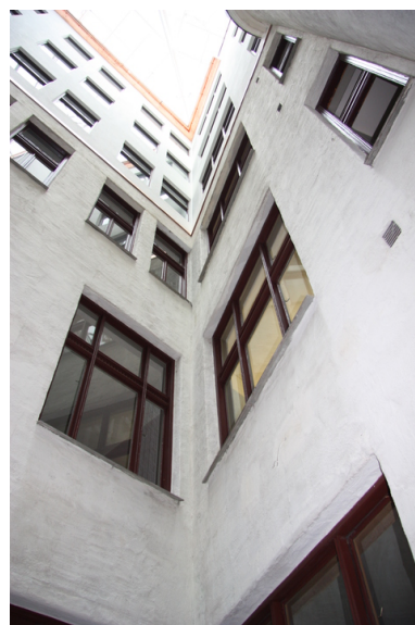
Fasadene mot øst og sør vender mot bakgården, som i forbindelse med ombyggingen til regjeringsbygg, R6, har fått glasstak over. Opphavsrett: Statsbygg.
