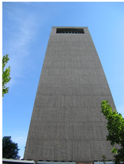
Fasaden mot syd med sine karakteristiske sandblåste relieffer i betongveggen. Opphavsrett: Statsbygg.
