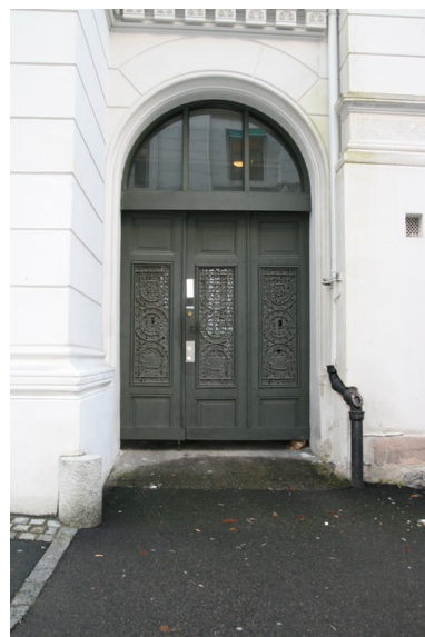
Detaljer på rehabilitert ytterdør. Opphavsrett: Statsbygg.
