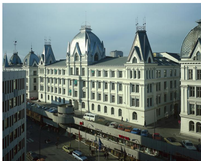
Midtkvartalet med dagens forretninger mot Ruseløkkveien. Opphavsrett: Teigens Fotoatelier.
